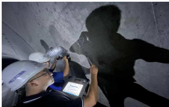
现场测试照片
