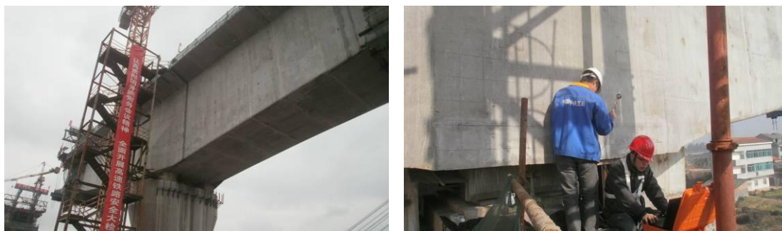
工程全景及检测情景
