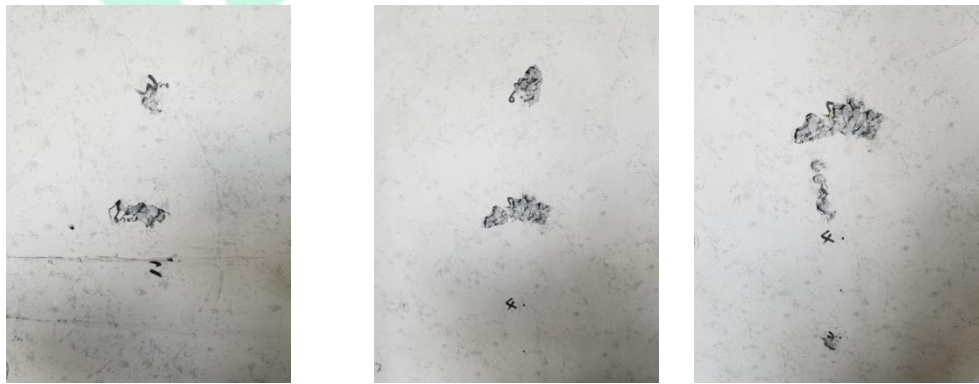
部分现场破检图
