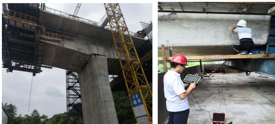
某高速大桥及左侧腹板现场检测图
