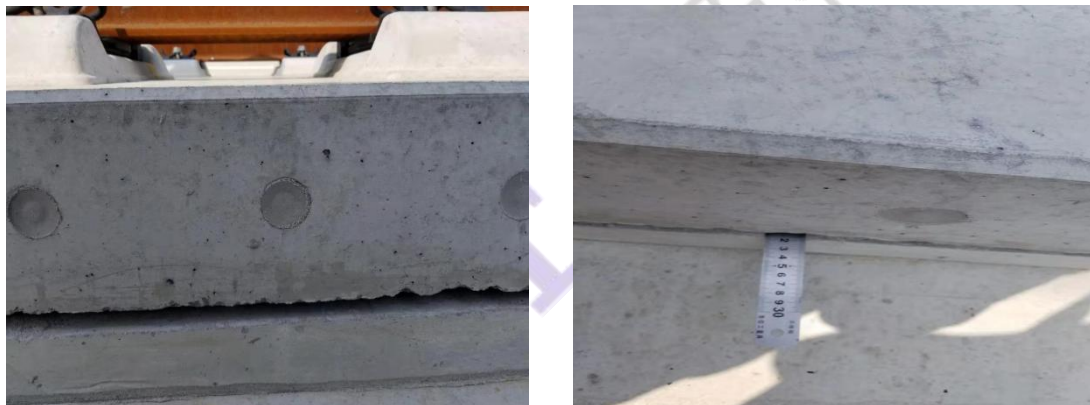
图 3-3-6 检测现场实际情况
