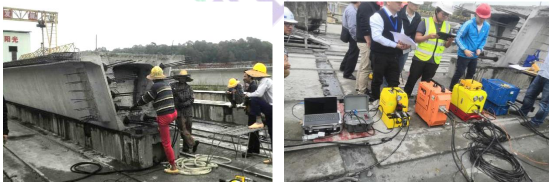
图 4-3-6 左：现场测试梁体 右：反拉设备（依次：升拓、T、武汉 Z、重庆 Z）
